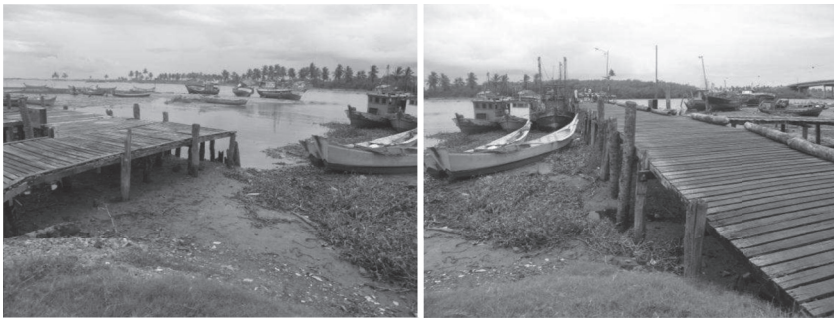
Figura 2: Comparativo para demonstração da modificação do atracadouro dos barcos devido à diminuição de profundidade do rio Japaratuba.
