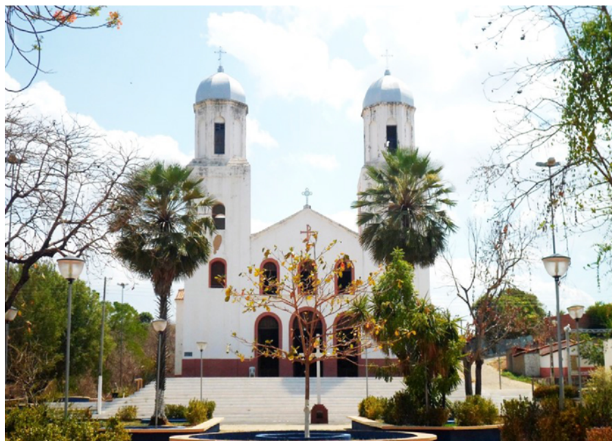
Figura 11. Igreja Matriz de São Gonçalo, município de Amarante/Piauí.
