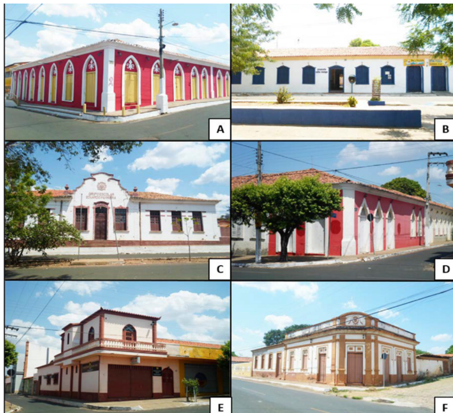
Figura 5: Casarões históricos: réplicas do estilo da arquitetura portuguesa no centro de Amarante/Piauí. A- Pontos comerciais. B- Pousada Velho Monge. C- Grupo Escolar Eduardo Ferreira. D- Casarão inativado. E e F- Casarões residenciais.
