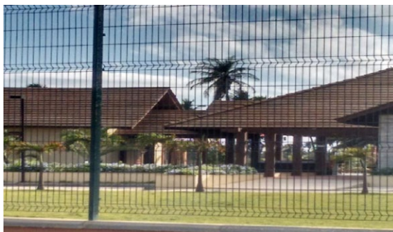
Figura 07. Fachada de recepção de Empreendimentos Imobiliários.
