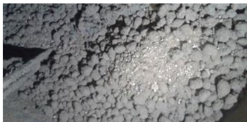
Figura 4 - Concretagem do traço com 100% de substituição (T4).
