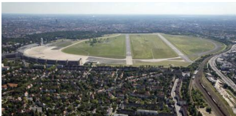
Figura 1: Vista geral do antigo aeroporto Tempelhof, em Berlim.
