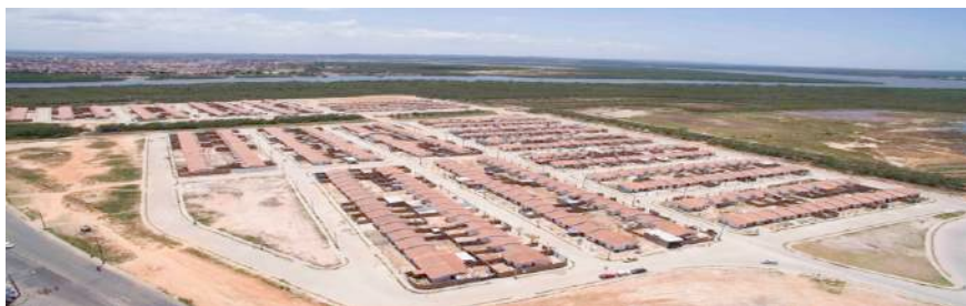
Figura 5: Construção Conjunto Residencial Senador José Eduardo Dutra no Porto Dantas, com 580 unidades habitacionais.
