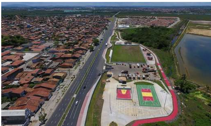
Figura 11: Vista parcial da Orla Fluvial do Porto Dantas - Aracaju-Sergipe Fonte: PMA (2018)
