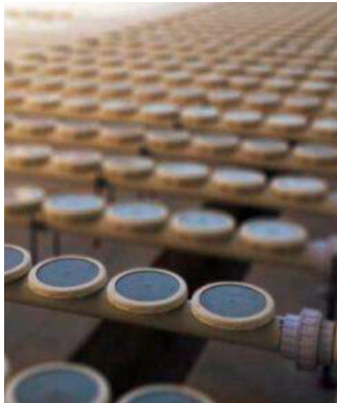
Fig 4 - Estação de tratamento de efluentes tipo Físico Químico
