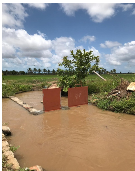
Comportas para distribuição de água nos lotes
