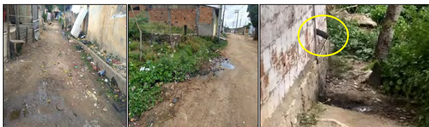
Figura 07 - Esgotamento sanitário inadequado, onde os efluentes são lançados nas vias ou as margens do Rio Pitanga, como mostra a foto em destaque.
