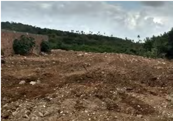
Figura 09: Aterramento do Mangue para a construção de uma estrada.
