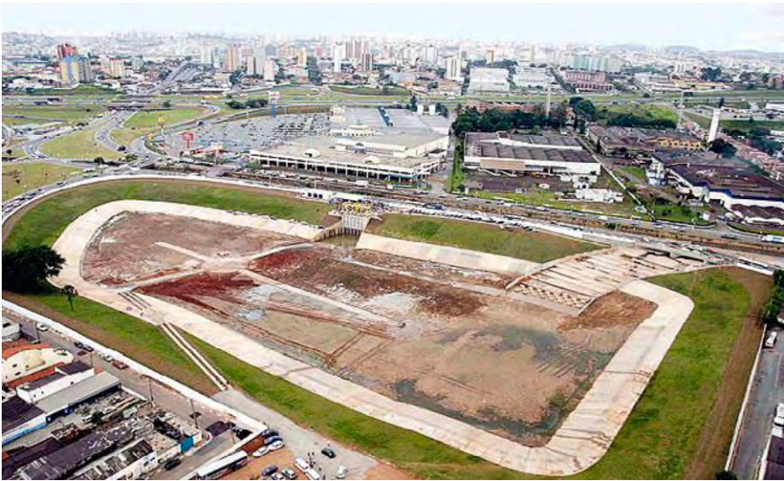
Figura 02 - Exemplo de bacia de detenção - Piscinão na Vila Paulicéia em São Bernardo (SP).
