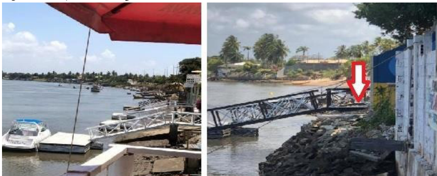
Figura 8 - Lançamento de esgotos in natura
