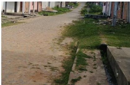
Figura 5: Esgoto na frente das residências.
