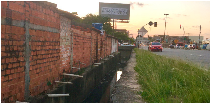
Figura 3 – Canal retificado do Rio Sal retificado, bairro Novo Paraíso, Aracaju/SE
