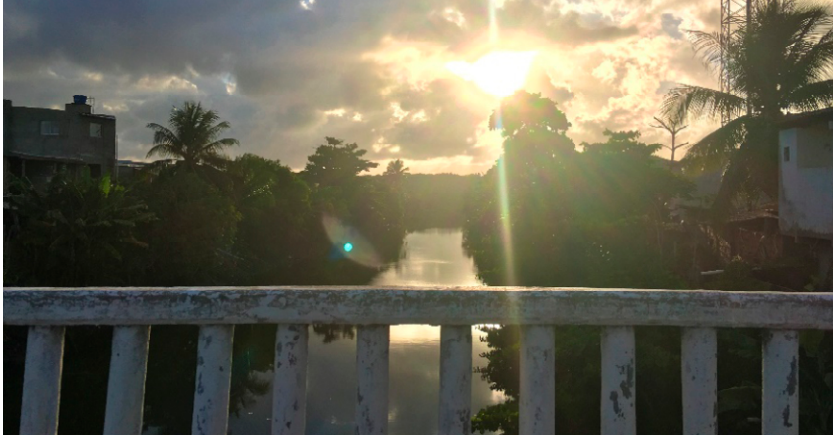
Figura 4 – Ponte sob o Rio Poxim, bairro São Conrado, Aracaju/SE.
