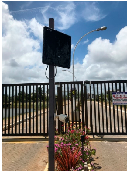
Figura 11 e 12. Entrada controlada por biometria e TAG de acesso magnético para veículos
