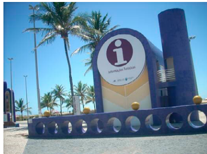
Figura 7. A cor azul que predomina nos prédios da Orla.
