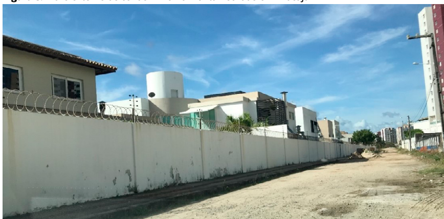
Figura 8. Muro externo de condomínio horizontal fechado em Aracaju
