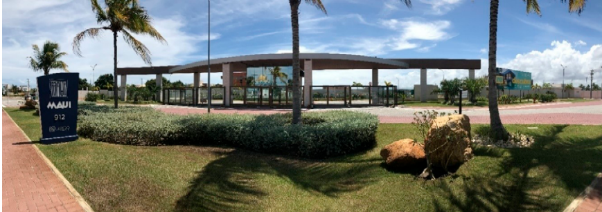
Figura 9. Guarita de condomínio horizontal fechado em Aracaju
