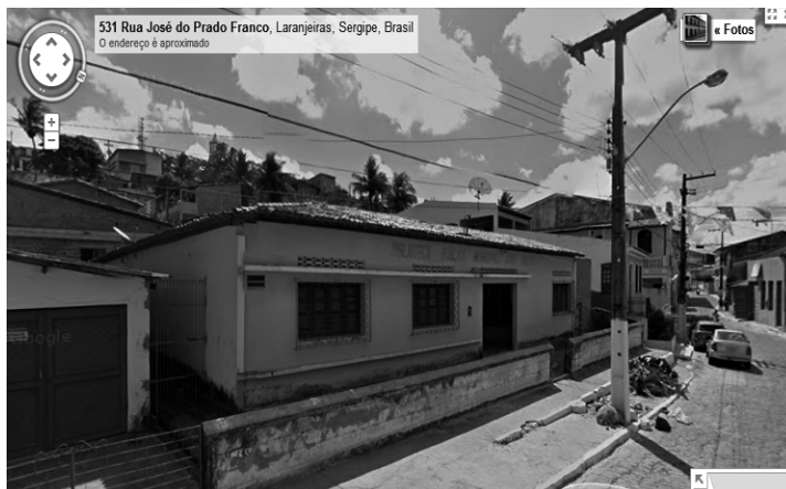
Imagem 09. Prédio atual da Biblioteca Pública Municipal João Ribeiro (BPMJR). Laranjeiras. 2012.
