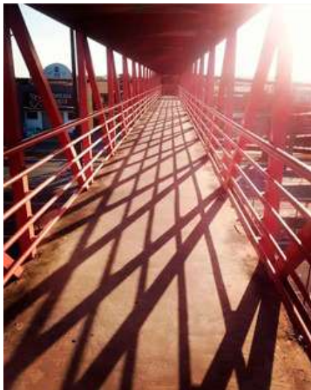
Passarela do Viaduto do Detran sob a Avenida Tancredo Neves, Aracaju-SE 9 .
