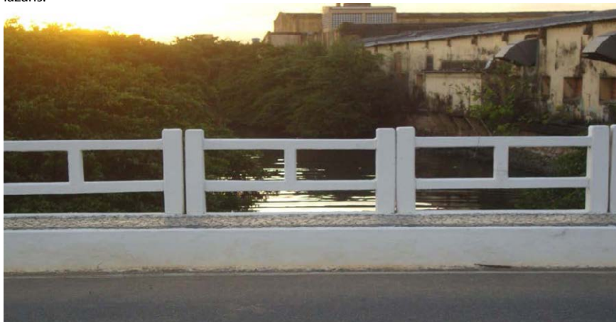
Figura 03. Ponte que liga o complexo dos Mercados Municipais de Aracaju com a Av. General Calazans.
