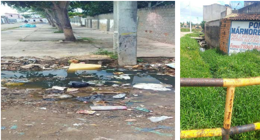
Figura 07 – A - Esgoto doméstico destinado ao rio Caiçá; B - Resíduos sólidos junto ao sistema de drenagem urbana, município de Simão Dias.
