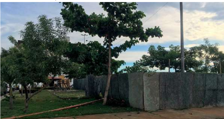
Figura 07 - Obra na Praça Newton Porto.
