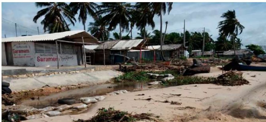
Figura 05 - Sacos utilizados para conter erosão costeira no povoado Saramém, em Brejo Grande/SE.
