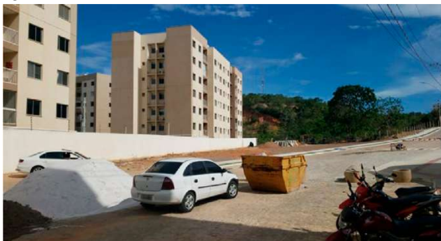
Figura 32 - Construções em andamento no trecho 4.
