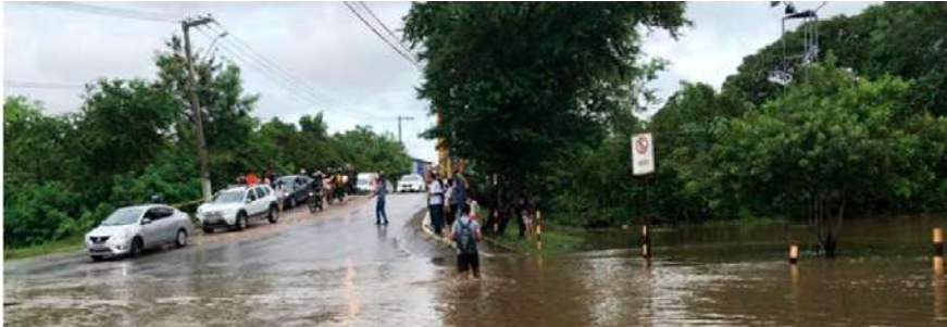
Figura 35 - Situação da ponte, que interliga os Conjuntos Sol Nascente e Santa Lúcia, durante as chuvas.
