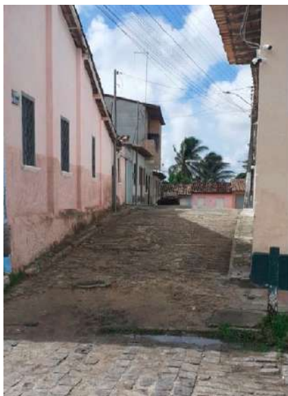
Figura 06 - Ausência de calçadas e falta de acessibilidade na entrada de edificações.
