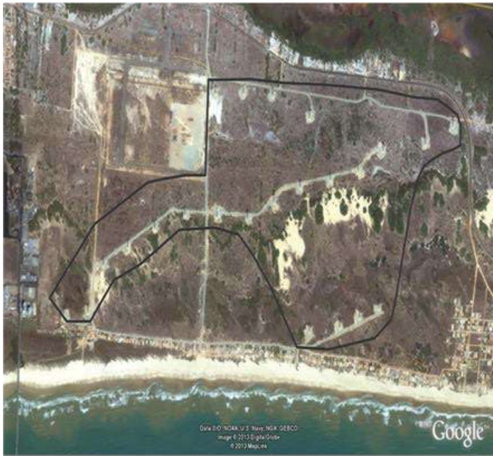
Figura 3: Distribuição parcial dos aerogeradores do Parque Eólico de Sergipe
