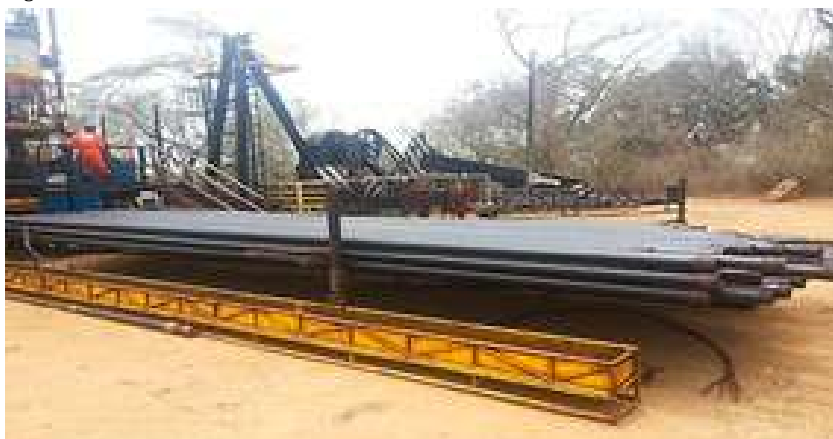
Figura 04 - Estaleiro de Tubos
