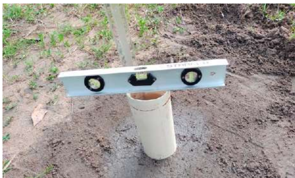
Figura 5 – Teste de infiltração efetuado in loco.
