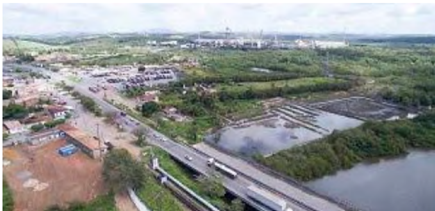
Figura 2: Ponte sobre o Rio Sergipe no bairro Pedra Branca
