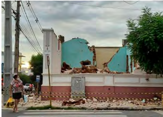
Figura 2: Casa no dia da demolição
