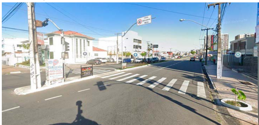
Figura 06 - Início do corredor da avenida Hermes Fontes Pós Reforma
