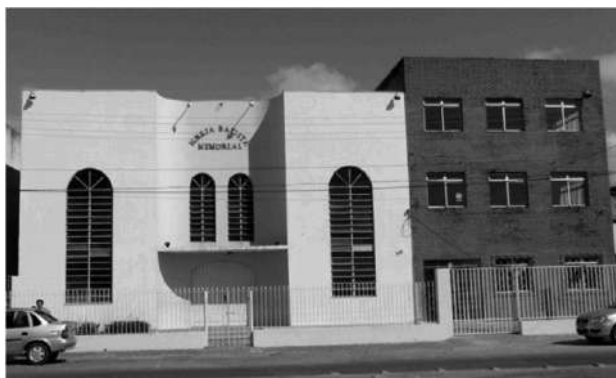
Igreja Batista Memorial à direita Edifício Memorial
