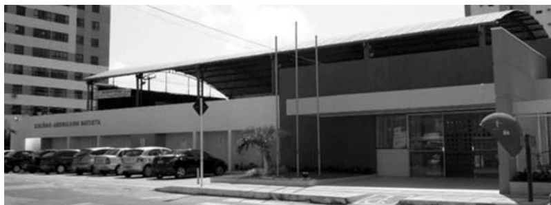
Novo prédio construído em 1986. Arquivo: CAB.
