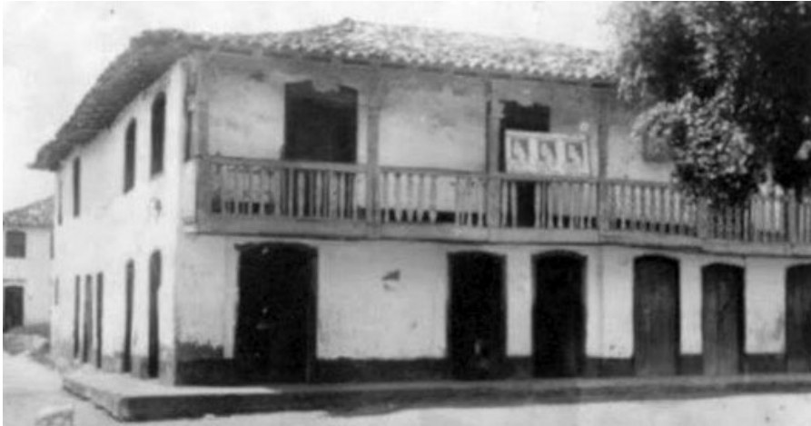
FIGURA XVI: Sobrado de balcão corrido na Praça Dr. Getúlio Vargas 24
