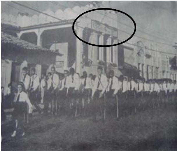
Imagem 62: Identificação da Placa na fachada do Colégio
