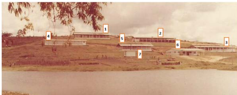
Figura 1 - Reforma dos aviários, década de 1970 (Avicultura - Zootecnia I)
