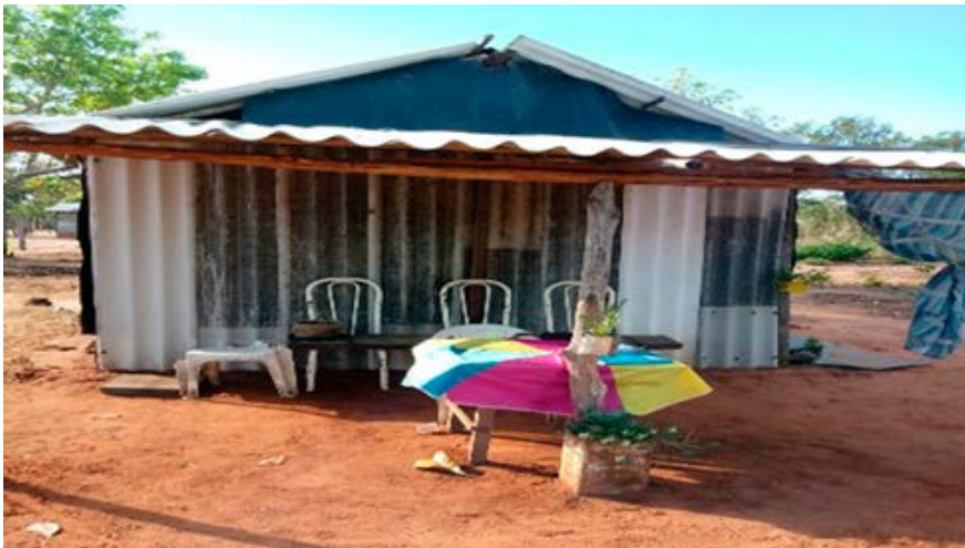
Figura 3 – Estrutura de casa da comunidade Garavelos
