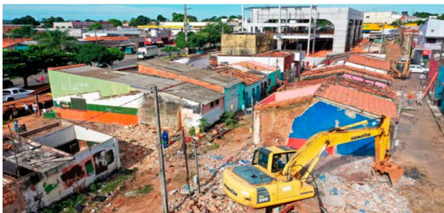
Figura 1 – Demolição da Feirinha, Araguaína(TO)
