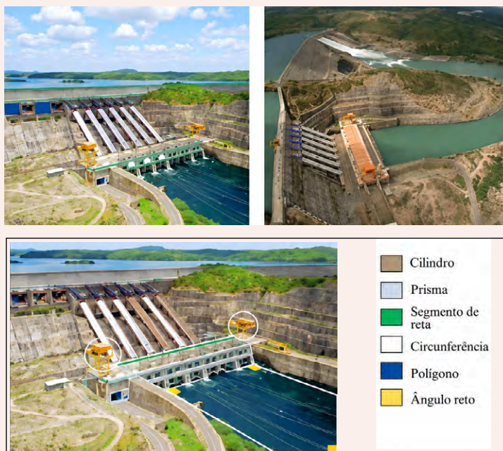
Figura 2: Análise realizada a partir de imagens da Hidrelétrica de Xingó
